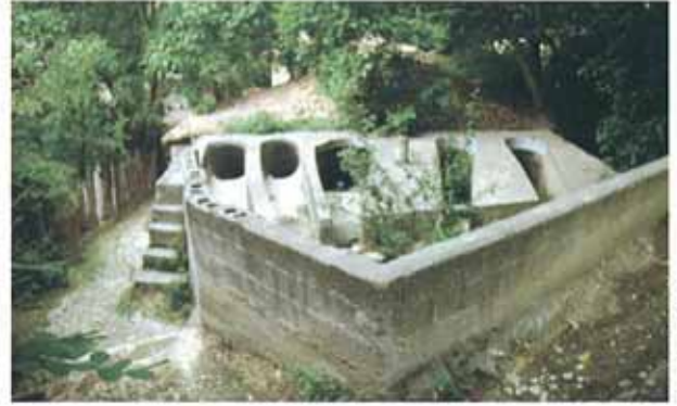
Res. 14. Şamlı'nın Degirmeni'nde beş gözlü havuz.
