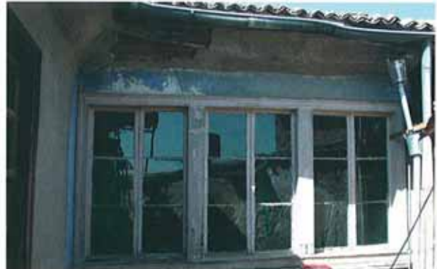
Res. 27. Aynı evin avluya bakan  st katından ayrıntı.
