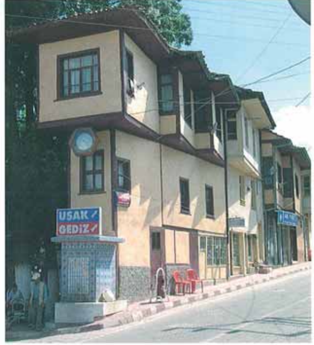
Res. 51. Cumhuriyet Caddesi üzerinde yer alan ve üzerinde bulunduġu parsel'e göre tasarlanan gönye çıkmalı sıra evler (env. no: K22B0096).
