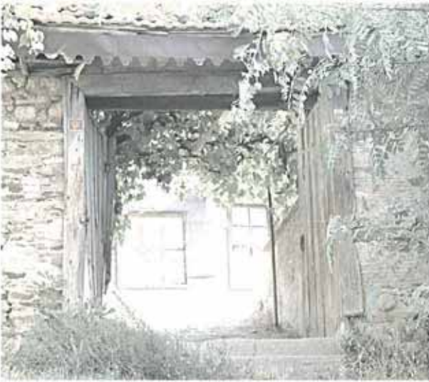
Res. 46 - 48. Buldan'ın genellikle ahşap, çift kanatlı ve sundurmalı olan bahçe kapılarından örnekler.
