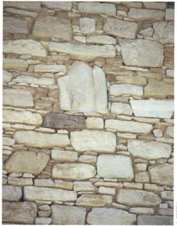
Res. 45. Celal Çamoglu evinin (L21C009.005) duvarında kullanılan devşirme taşlar, Çağış Mahallesi, Buldan.
