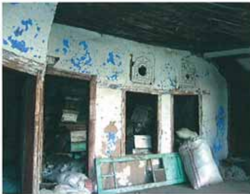
Res. 8 - 9. Evin birinci katında bulunan, "pahlı" duvarlarla çevrili dış sofanın, buraya açılan kapılar ve "revzen" tepe pencereleriyle günümüzdeki durumu.
