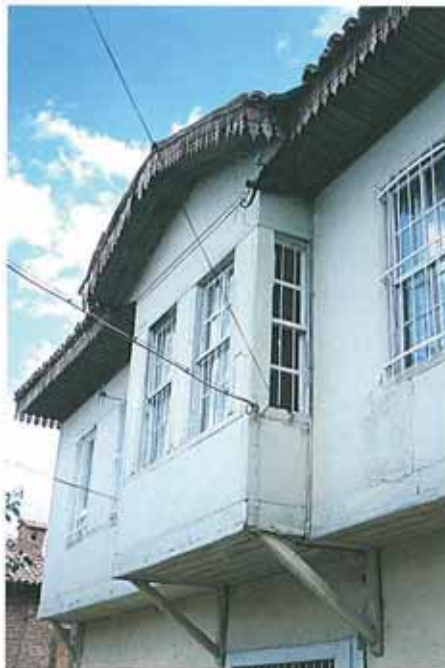
Res. 29. Saçak kenarındaki sac malzemede bezeme örneđi.
