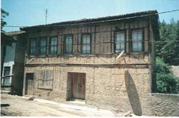
Res. 18. Kerpiç dolgulu ahşap karkas yapı (env. no: H22C001.055).
