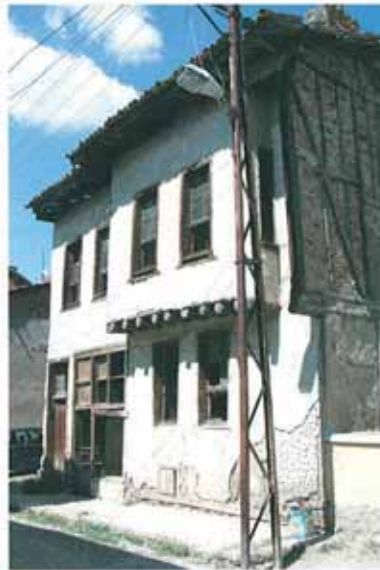
Res. 37. Dışarı taşan döşeme kırışlarına oturtulan, altı kaplamasız çıkma (env. no: K22B030).
