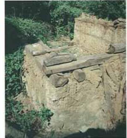
Res. 44. H22C001.041 envanter numaralı yapının güneyindeki ahşap yapının hatıllı kerpiç duvarı.
