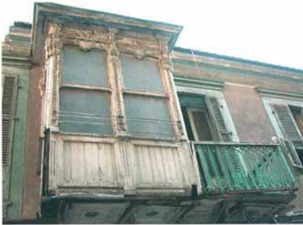
Res. 18. Cumba ve a ık  ıkmanın birlikte kullanıldığı bir  rnek (360 ada, 26 parselde bulunan L18B766 envanter numaralı yapı).
