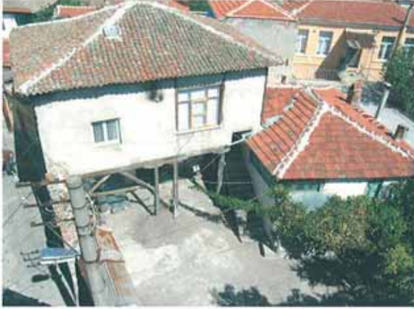
Res. 5. Bergama'nın Sel uk Mahallesi'nde 414 ada 51 parselde bulunan ev (env. no: J18B0143).
