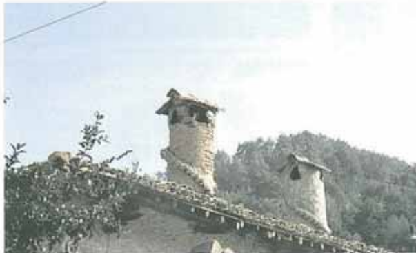
Res. 36 - 37. Buldan'ın baca örneklerinde, çoğunlukta birer tuğlanın basamaklı olarak dışarıya taşınmasıyla elde edilen bir biçimlenme dikkat çeker.
