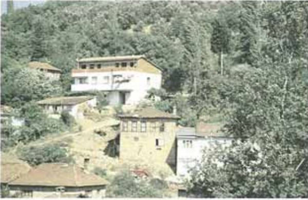
Res. 49. Köy içinde yeni betonarme yapılar.
