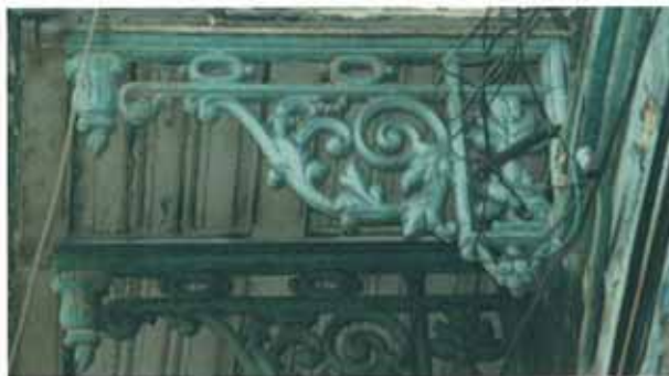
Res. 20. Cumba altı konsol elemanlarından bir  rnek (382 ada, 73 parselde bulunan L18B793 numaralı yapı).
