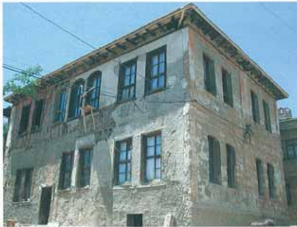
Res. 49. Ahşap karkas yapının dışına yığma tuğla ikinci bir duvarın örülmesi uygulaması (env. no: K22B0038).
