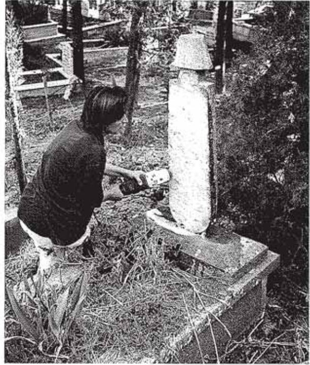
Res. 14. Zamanla kirlenip üzerlerinde tabakalar oluşan taşlar çalışma sırasında el spirali ile temizleniyor.
