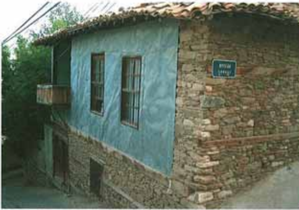
Res. 21. Cephede sac kaplama ve sıvasız duvar (env. no: L21B1227), Helvacılar Mahallesi.
