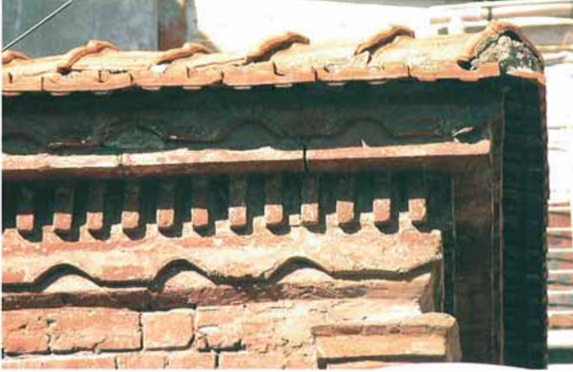
Res. 22. Saçak bordürü detayı (Anafartalar Caddesi - 863. Sokak köşesindeki L18B592 envanter numaralı yapı).
