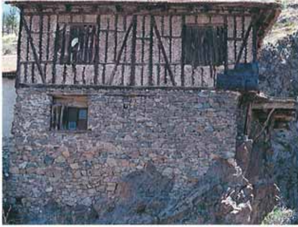
Res. 34. Kayalık zeminde, kayaların kısmen duvar olarak kullanıldığı bir yapı.
