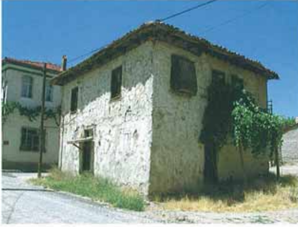
Res. 32. Kurtuluş Mahallesi'nde, yerleşimin ilk yapılarından bir örnek. Üst katta, cephenin sağındaki ahşap çıkma 'sütlük', serin yerde saklanması gereken yiyecekler içindir.
