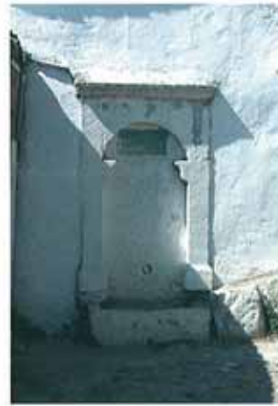
Res. 39. Selçuk Mahallesi'nde bulunan bir çeşme (env. no: J18B0153).
