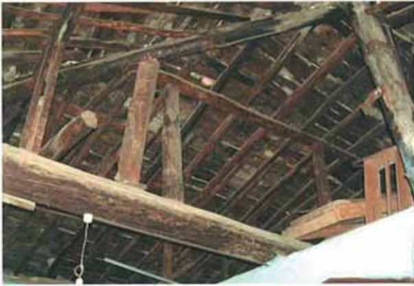
Res. 32 - 33. Buldan'da çatı altı açık bırakılan, böylece yapım tekniğini izleme olanağı sağlayan örneklerden biri.
